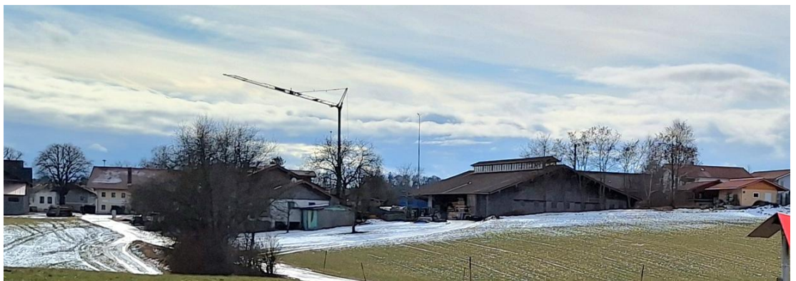
Abb. 3 Ansicht vom Norden auf das Plangebiet, ohne Maßstab, Quelle: PV, Stand Januar 2026
