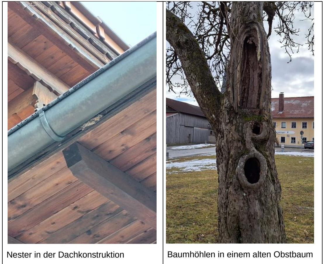
Abb. 8-13 Habitatstrukturen gemäß Bestandsaufnahme vom 26.01.2026
