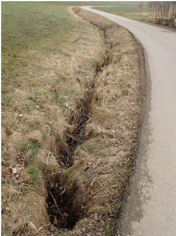
Abbildung 5: Vorhandener Entwässerungsgraben nördlich der Erschließungsstraße.
