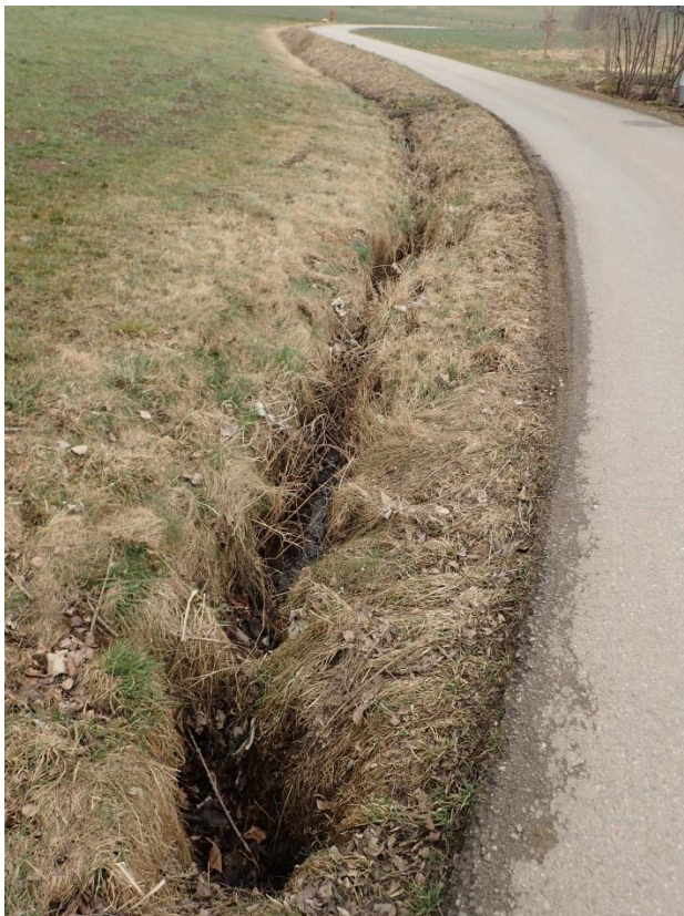
Abbildung 8: Vorhandener Entwässerungsgraben nördlich der Erschließungsstraße. Quelle: Eigene Aufnahme vom 17.03.2022.
